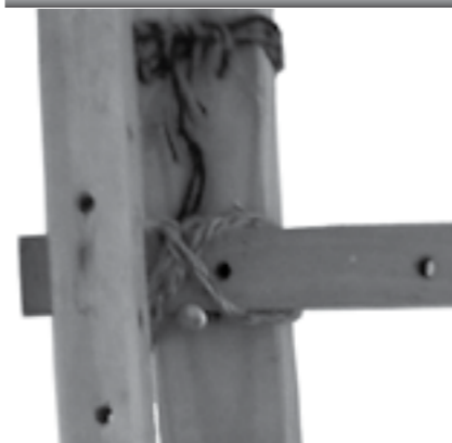
Wixa-wixal: largueros verticales que dan soporte a la estructura.
